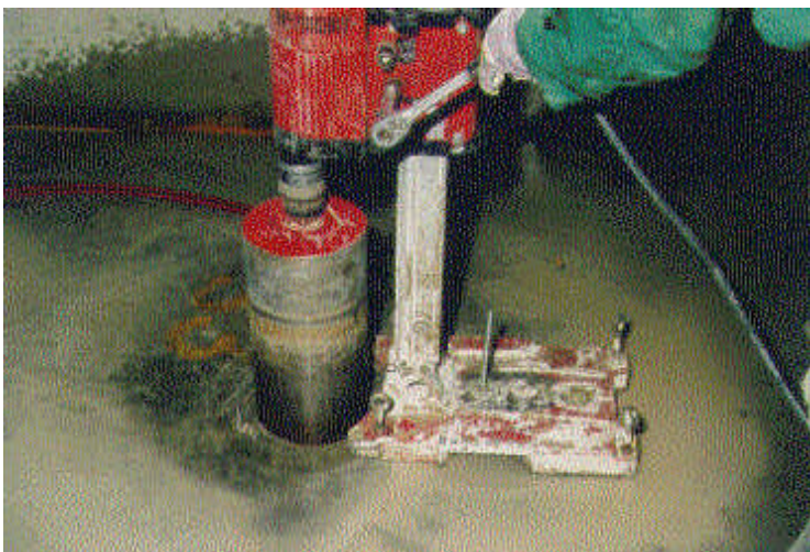
Abb. 7: Kernbohrung durch den Hallenboden (Betonplatte)
