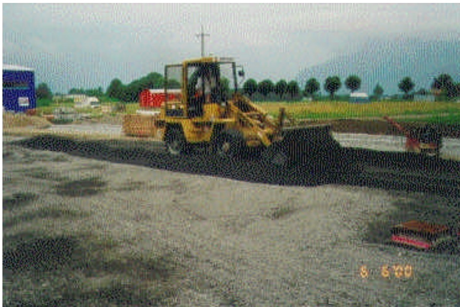
Abb. 10: Aufbringung des Schlackeplanums mittels Radlader am Tag der Probenahme
