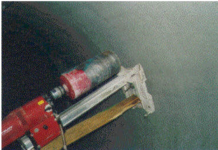
Abb. 8: Kernbohrung in einem Versorgungsschacht unter dem Schlackekörper
