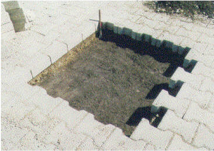
Abb. 9: Beprobung einer Schlackegründung durch Abtragung der Betonstein-/Splitt-Überdeckung
