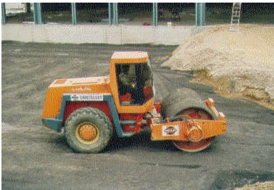
Abb. 11: Verdichtung der eingebauten Müllverbrennungsschlacke mittels Vibrationswalze am Tag der Probenahme
